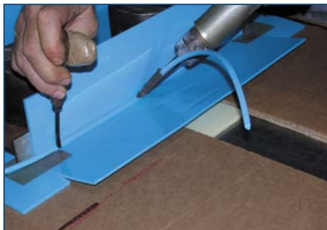
Приваривание перегородок с использованием электрода
